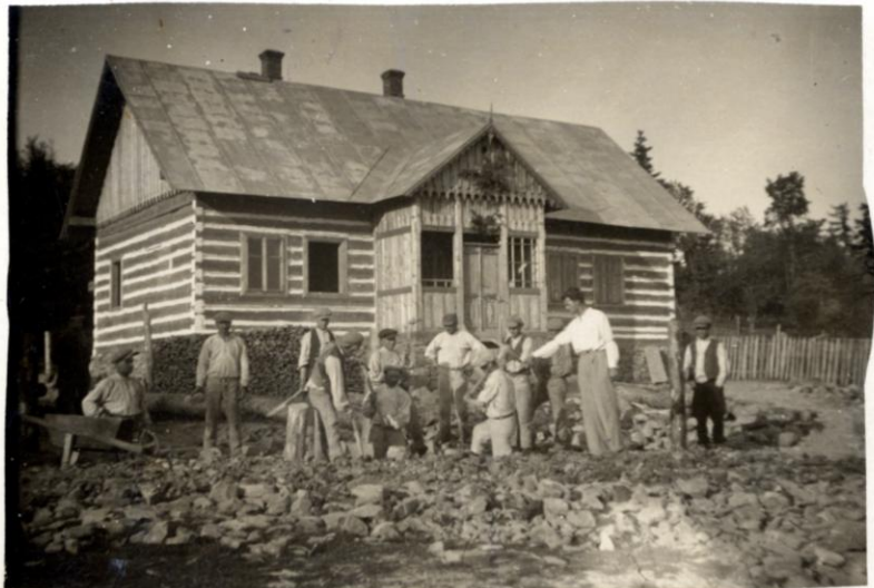
Budowa Szkoły: Jasol.
