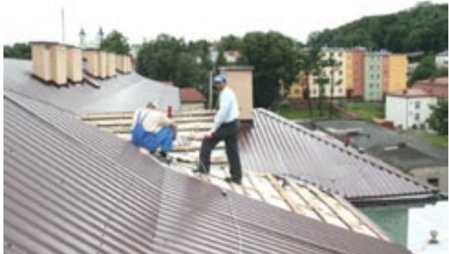
Austriacki budynek, w którym mieści się „ekonomik”, od dawna wołał o remont. Szczególnie pilnym zadaniem była wymiana dachu.
