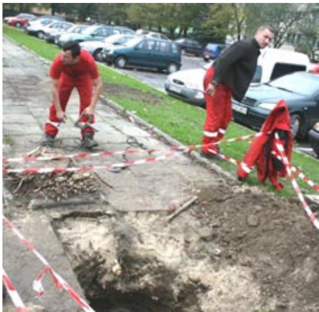
Odkopanie zasypanych studzienek wymaga niekiedy zdjęcia kilku warstw o grubości dochodzącej nawet do jednego metra.
