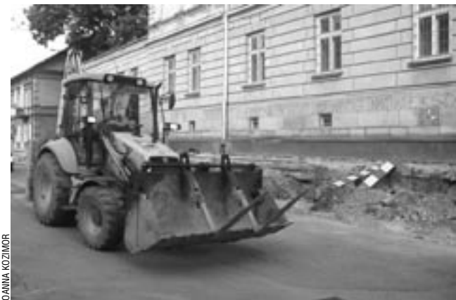
Prace remontowe ekipa Rymtaru rozpoczęła od usunięcia krawężników i schodów przy budynku byłej komendy policji.
