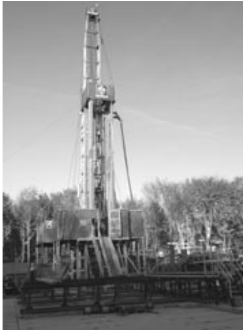
Za sprawą naftowców Strachocina stała się wielkim placem budowy.
