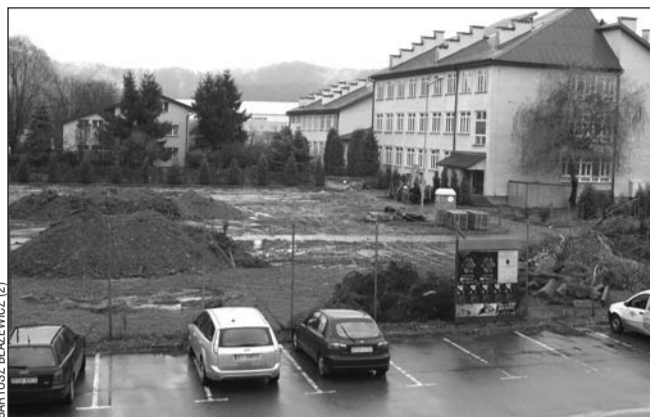
Boisko przy SP1 to na razie plac budowy, ale za trzy tygodnie „Orlik” na być gotowy.
