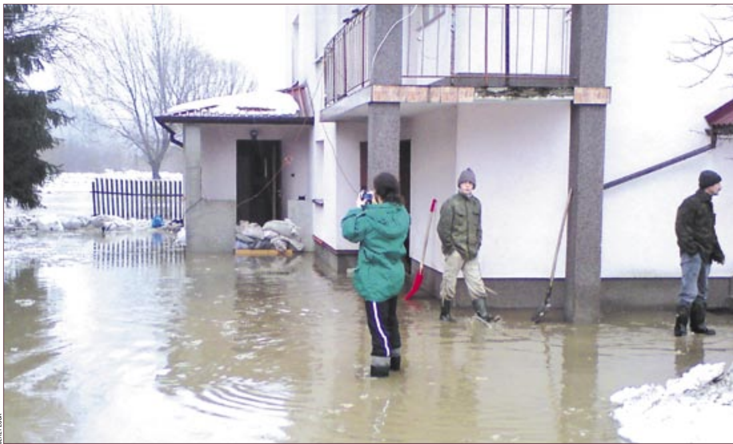
W tym domu woda zalała piwnice i cały parter. Straty są ogromne. Mieszkające się na dole mieszkanie córki i zięcia – dopiero co odnowione – zostało całkowicie zniszczone...
