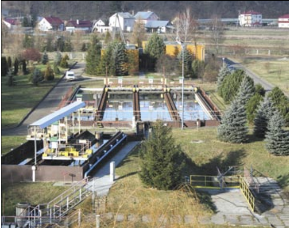
Na zdjęciu sanocka oczyszczalnia ścieków prezentuje się świetnie. Ale wygląd to nie wszystko. Przede wszystkim ma osiągać wysokie parametry oczyszczania, a do tego potrzebuje już rozbudowy i modernizacji.
