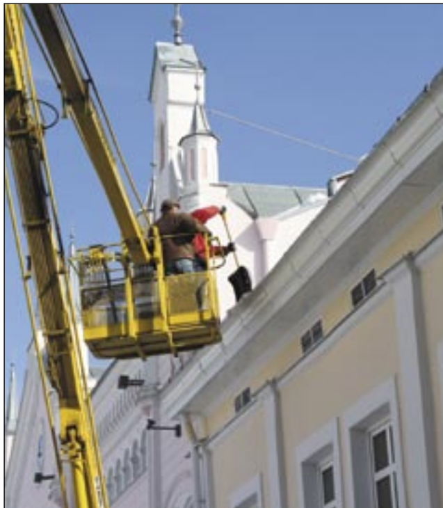
W poniedziałek oczyszczano dach budynku ratusza. Choć jest po remoncie, licho nie śpi, a zbity śnieg sporo waży...
