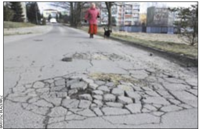
Zima pozostawiła na drogach nie tylko głębokie dziury, ale i wysokie wyrzyszenia. Nawet takie, na których można urwać za wieszanie.
