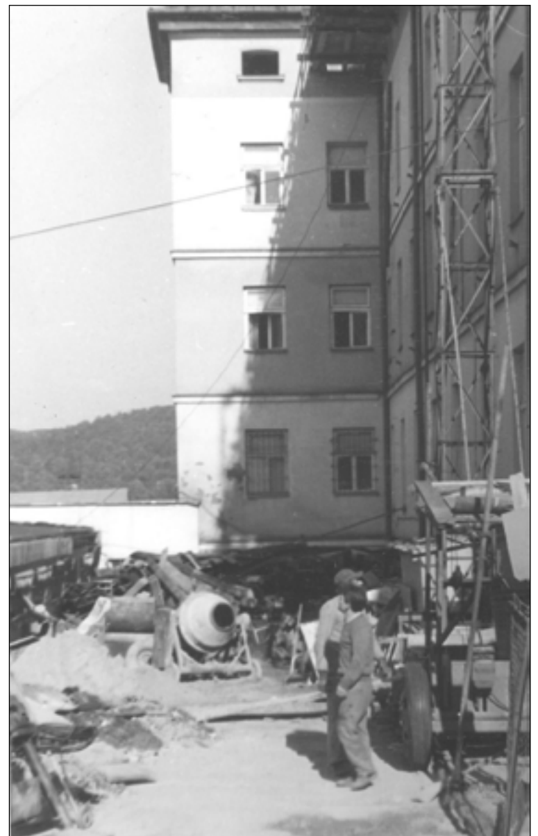
Rok 1987 – dobudowa najwyższego piętra Szkoły.
