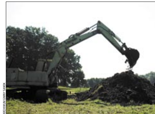
Prace przy budowie kanalizacji w Strachocinie powinny nabrać tempa.
