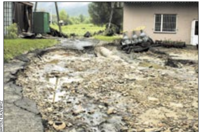
Woda zalewająca posesje potrafiła siać prawdziwe spustoszenie, zdzierając nawet asfalt.
