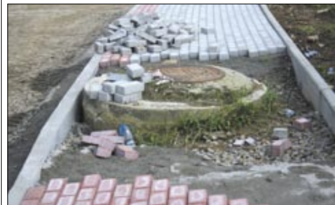
A to rewolucyjny patent, żeby studzienki nie przeszkadzały samochodom w ruchu ulicznym. Pieszemu zawsze łatwiej będzie ją przeskoczyć.
