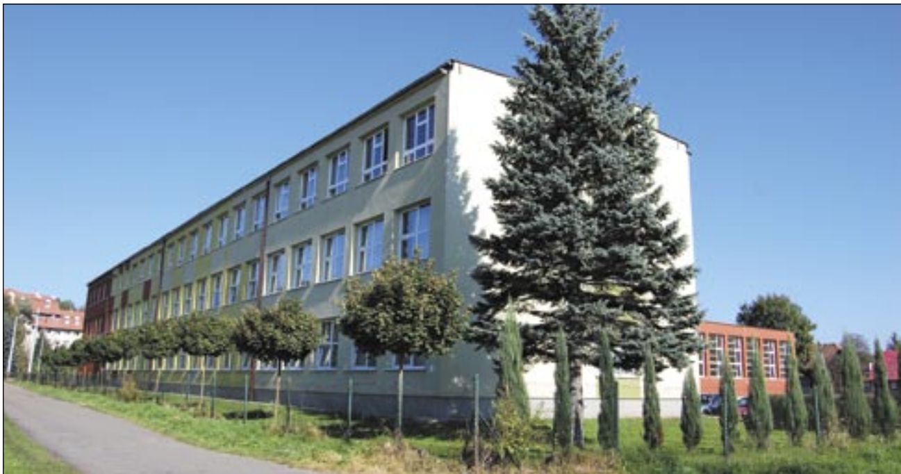
Obiekt I LO przy ulicy Zagrody pięknie przysposobił się do jubileuszu 130-lecia, przywdziewając odświętną szatę w postaci nowej elewacji.
