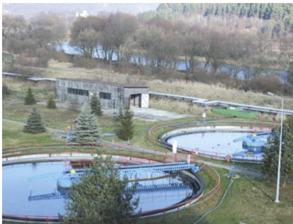
89 mln dofinansowania zdobyto na modernizację ujęcia wody i oczyszczalni ścieków.
