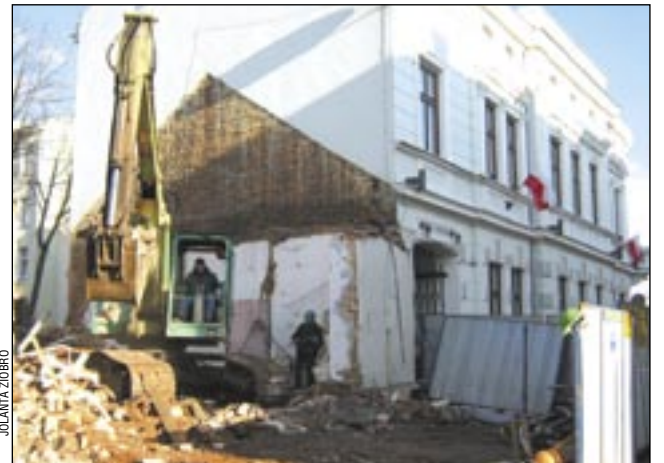
Na dziś kamienica jest już wyburzona i trwają prace ziemne
