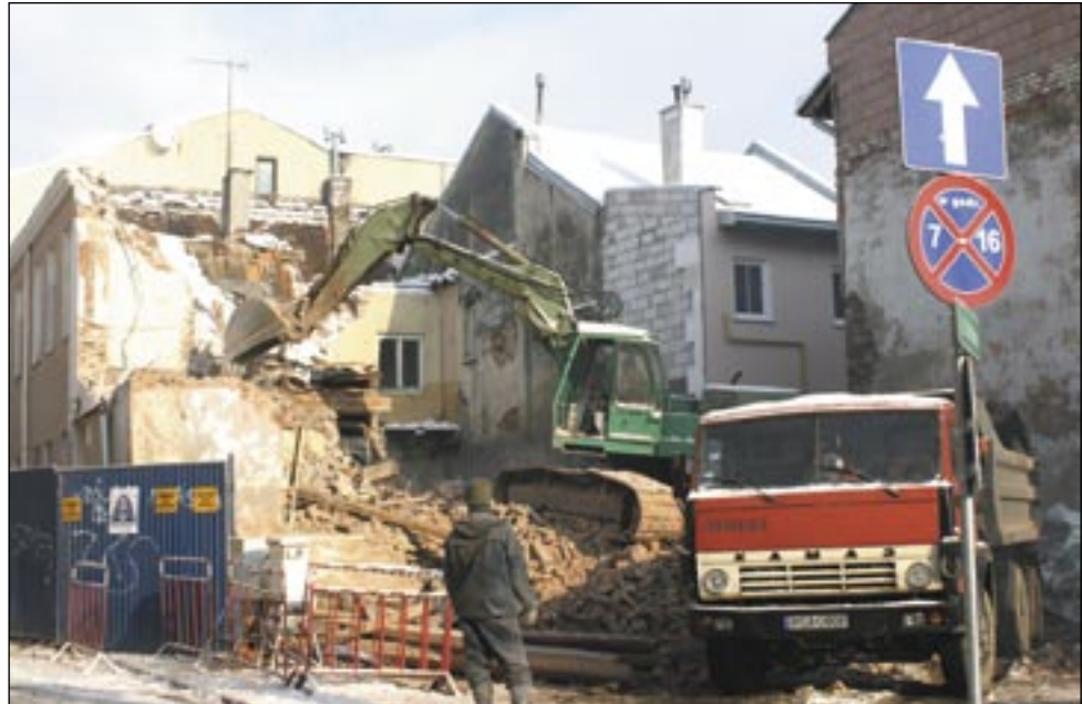
Jeszcze kilka dni temu w tym miejscu na rogu Rynku i ul. Cerkiewnej straszyla rudera, a przed nią chwasty i błoto, dziś jest to już plac budowy, na którym stanie piękna kamieniczka. Oczywiście w urokliwym, starym stylu.
