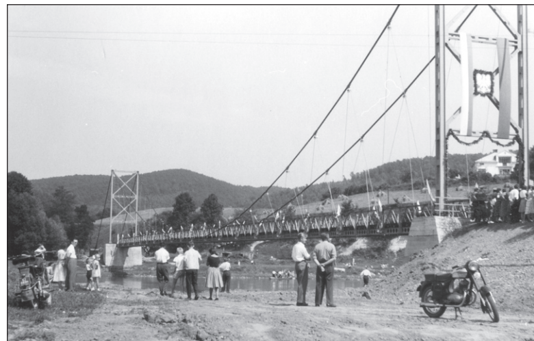
Sierpień 1959 rok – oddanie wiszącej kładki na Białą Górę. Zaprojektowali ją naukowcy z Politechniki Warszawskiej po tym, jak pierwszą kładkę łączącą brzegi Sanu zerwał silny podmuch wiatru. Ta, wybudowana pod koniec lat 50., funkcjonowała aż do połowy lat 80.
