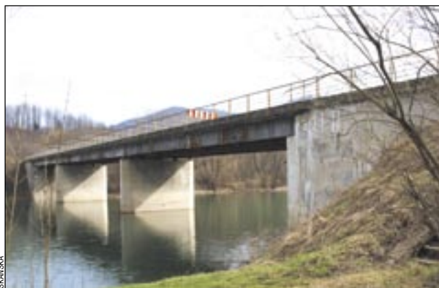
Choć kilkumiesięczny remont mostu w Rajskim utrudni życie tubylcom i turystom, nie można było dłużej z tym zwlekać.
