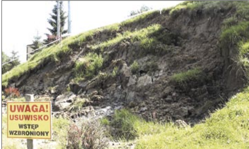
Osuwisko na zagórskiej Dolinie powstało przed rokiem, ale każda większa ulewa potęguje zagrożenie.
