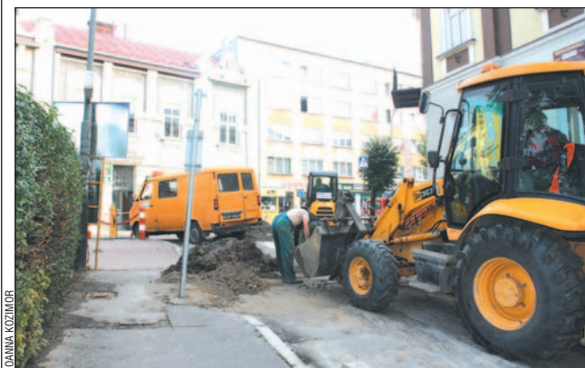
Jednym z wielu frontów drogowych robót jest ul. Daszyńskiego.
