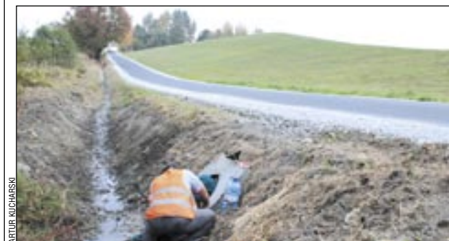
Przepust już udroźniono, a robotnicy odmulają rowy. Pozostaje sobie życzyć tylko jednego: aby jak najszybciej ruszył remont odcinka ulicy Stróżowskiej, który należy do miasta.
