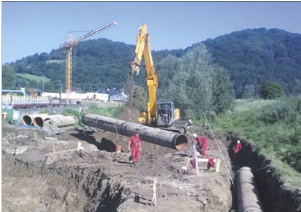
Teren sanockiej oczyszczalni ścieków zamienił się w wielki plac budowy. Rządzi na nim rzeszowska INŻYNIERIA, a tempo prac ma prawo zadowolić inwestora.
