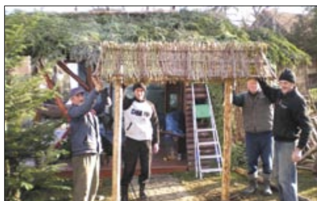
Budowniczości przy pracy.
