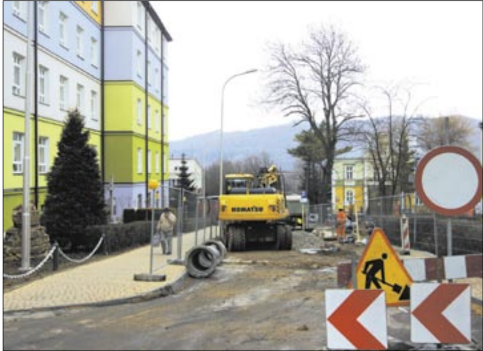
Rewitalizacja Śródmieścia rozpoczęła się od ulicy Sobieskiego. Choć to już grudzień, pogoda sprzyja budowlącom.
