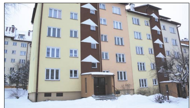
O spowodowanie problemów „podejrzewane” było nawet docieplenie. – Wszystko zostało wykonane zgodnie ze sztuką budowlaną, poprawiła się termoizolacyjność ścian budynku oraz ich szczelność – mówi A. Ostrowski.
