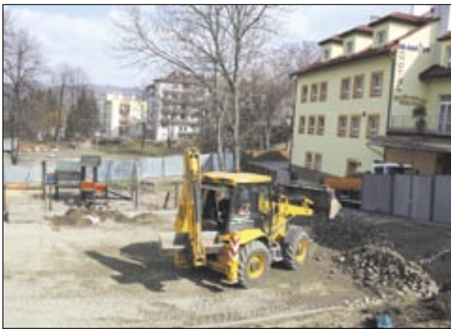
Demontaż parkingu obok Sanvitu.
