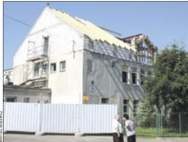
Budynek spółdzielni rośnie jak na drożdżach.
