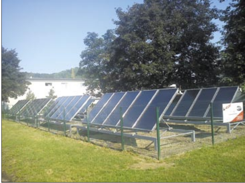
Solary ostatecznie zamontowano nie na dachu, tylko na ziemi. Jak wyliczyli fachowcy, okres zwrotu nakładów wynosi 65-71 lat, podczas gdy instalacja może służyć mniej więcej 20 lat.
