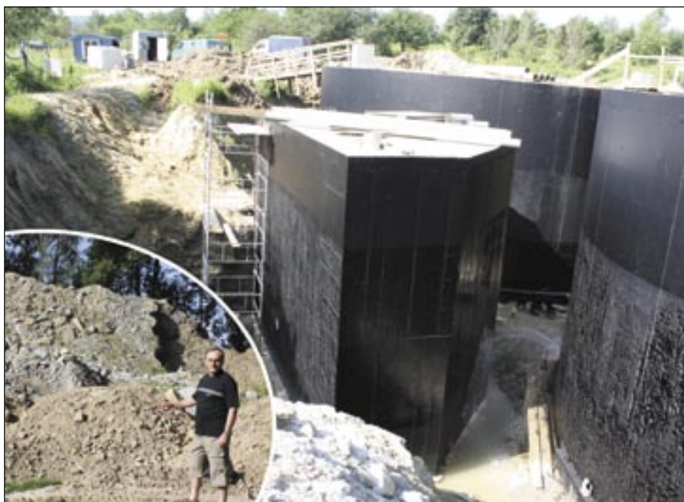
Zbiorniki przy ul. Kenara robią wrażenie. Ziemia z wykopów utworzyła na boisku prawdziwą górę. Społecznicy z rady dzielnicy liczą, że wkrótce zniknie, a boisko wróci do dawnej świetności.
