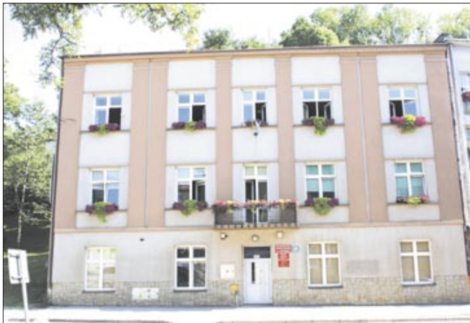
Stara chałupa, a trzeba inwestować. Remont budynku przy Kościuszki będzie kosztował ponad 200 tys. zł.
