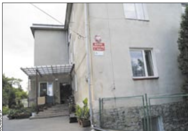
Budynek leciwej bursy przy Chopina. Już niedługo zyska nową, piękną elewację.
