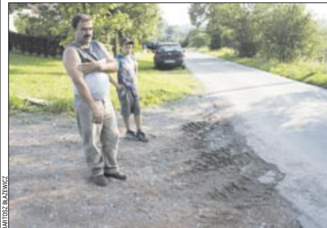
Po rozkopaniu drogi osiedlowej tworzą się błotniste kałuże, zwłaszcza w miejscu jej styku z głównym traktem Stróży Wielkich.
