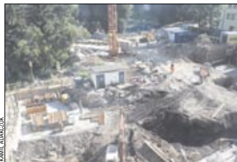
W przypadku tej inwestycji potwierdza się budowlana stara prawda, iż najtrudniej jest wyjść z ziemi.
