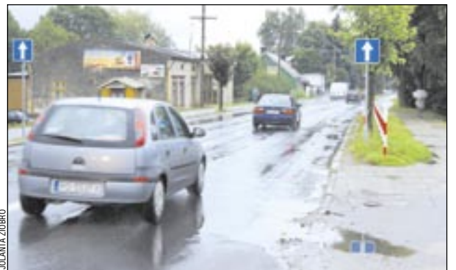
W Polsce nie ma chyba tak zaniedbanej „krajówki” jak ulica Lipińskiego naszym mieście. Na chodniku w niektórych miejscach można połamać nogi.
