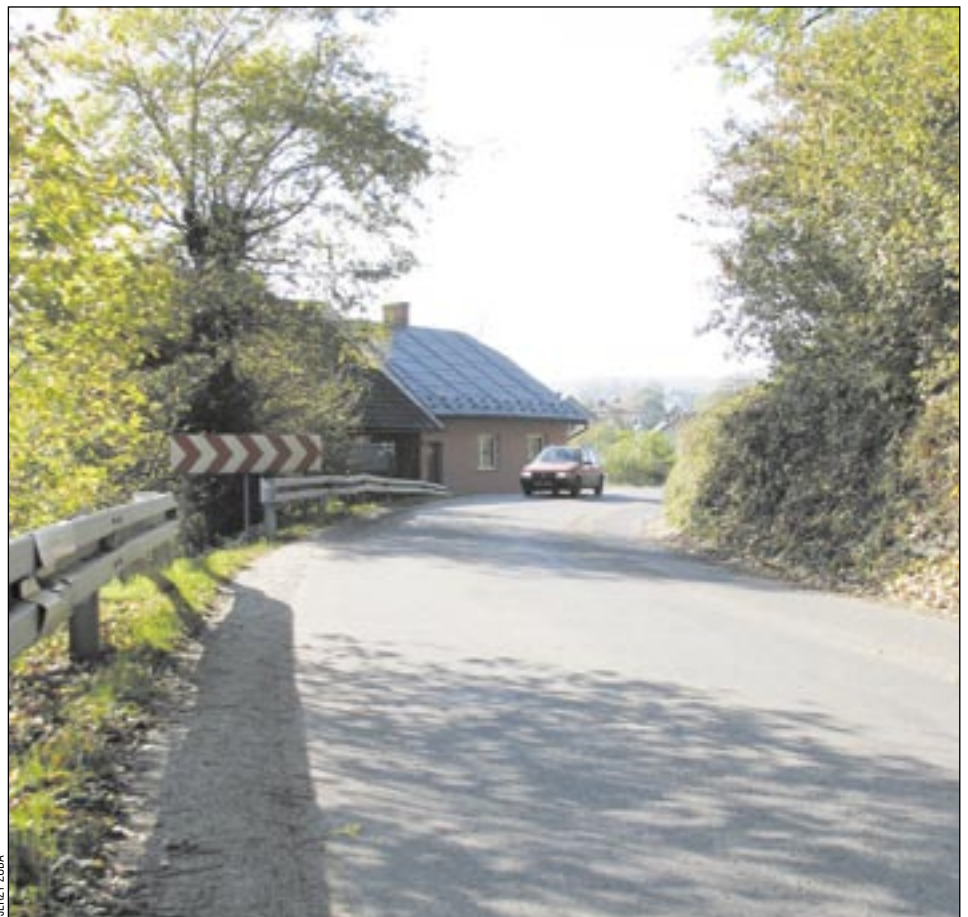
W ramach zadania zostanie także przebudowany bardzo niebezpieczny zakręt w Tarnawie Dolnej, gdzie droga ma szerokość zaledwie 5 metrów. – Uzyskamy jezdnię o szerokości 6,5 metra oraz chodnik dla pieszych – informuje Marek Szpara z PZDW.
