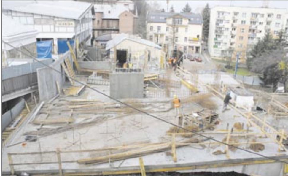
Obiekt wkomponowany jest w naturalne wgłębienie terenu, dlatego nie widać jego potężnych gabarytów.
