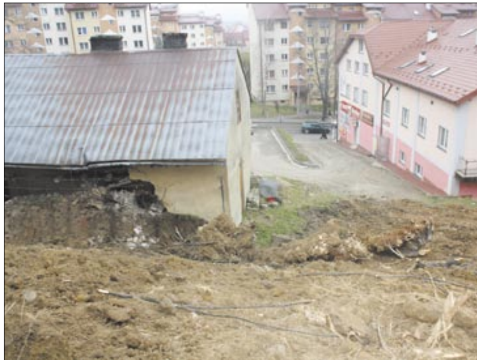
Z Góry Parkowej trzeba w pierwszej kolejności odprowadzić wodę.
