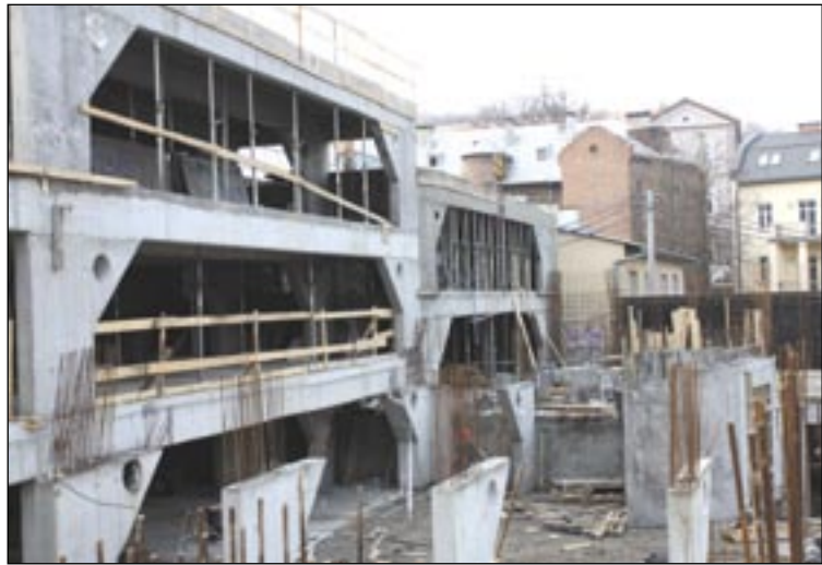
Wielopoziomowy parking w centrum rośnie w oczach. Budowlancom Skanskiej nawet zima nie przeszkadza w kontynuowaniu prac.
