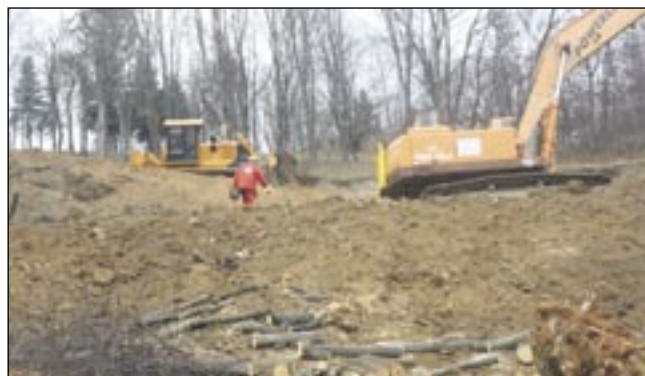
Dzięki w porę podjętym pracom zabezpieczającym osuwisko, jest nadzieja, że nam Góra Parkowa nie zjedzie na ulicę.
