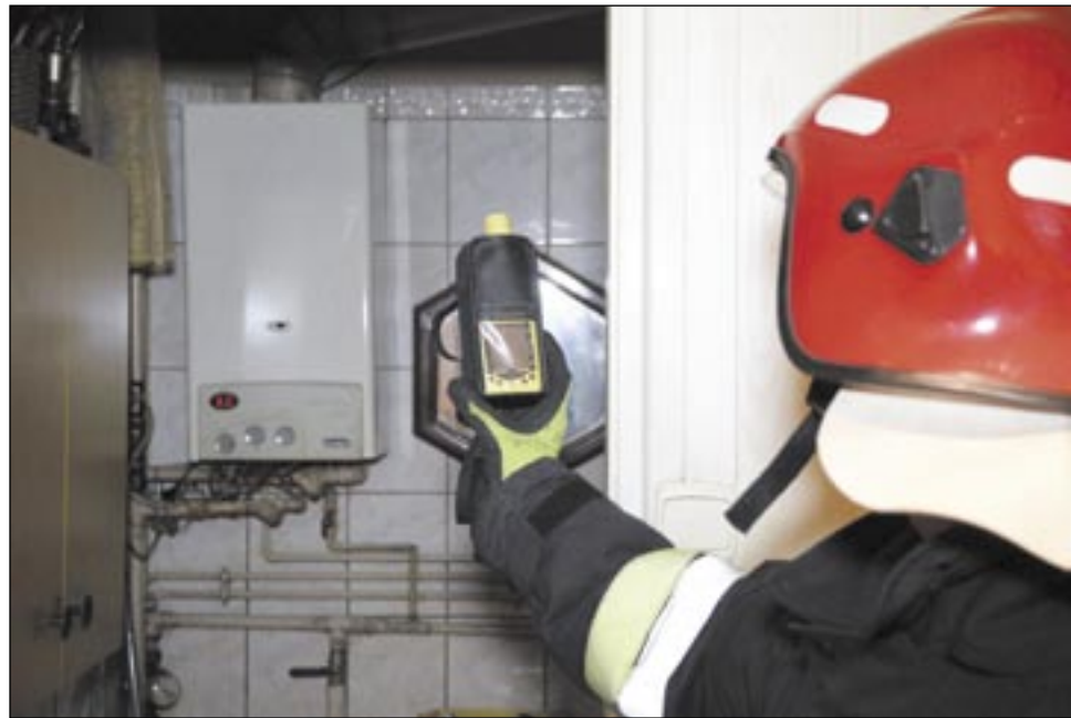
W małych pomieszczeniach kontrole powinny być przeprowadzane co 3 miesiące.
