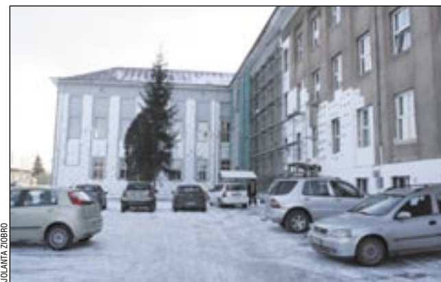
Termomodernizacja „mechanika” już trwa.
