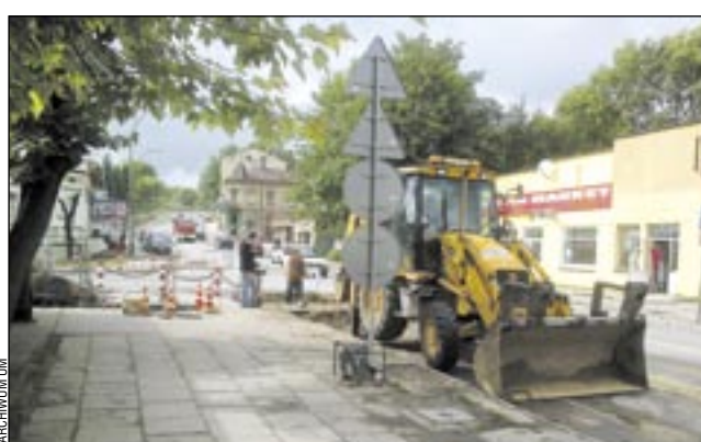
Remont trzech głównych ulic w mieście w czasie trzech miesięcy. Przed niełatwym wyzwaniem staje firma „Strabag”, która jako jedyna zdecydowała się na wykonanie tego zadania.
