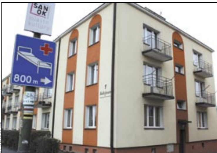
Blok przy ul. Kolejowej ma już swoje lata, ale zdaniem SPGM stan dachu nie jest jeszcze najgorszy.
