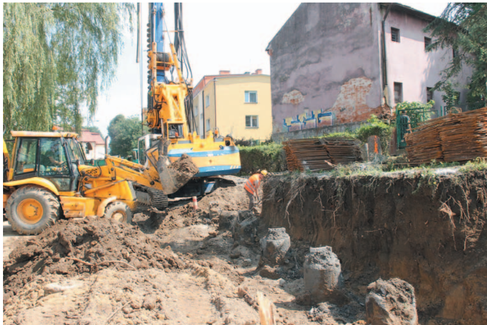
Przy ulicy Szopena trwają potężne prace ziemne
