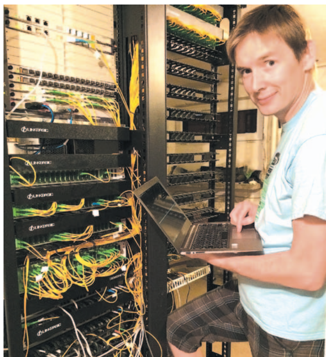
Roman Romanowski w trakcie prac serwisowych w punkcie dystrybucyjnym sieci światłowodowej w Sanoku.
