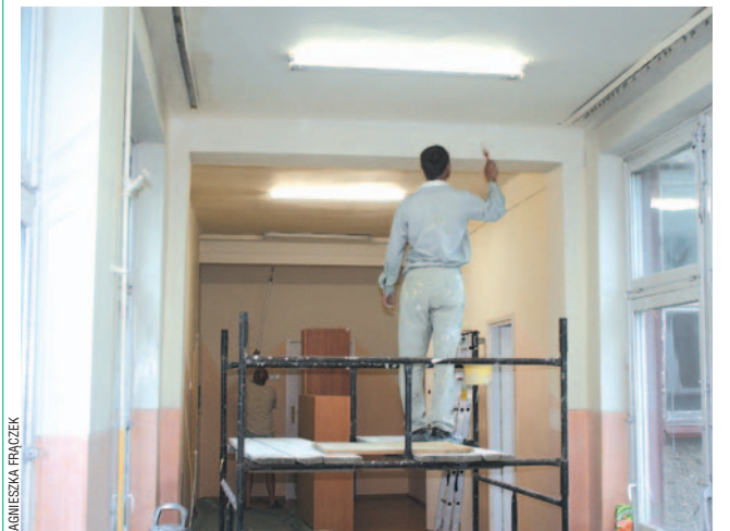
Przedszkole nr 3 już po raz drugi korzysta z pomocy osadzonych z Aresztu Śledczego. Dzięki tej współpracy placówka sporo oszczędza na remontach. Trzy lata temu wartość przeprowadzonych prac opiewała na 32 tys. zł! Kolejne tysiące zostaną oszczędzone w tym roku.
