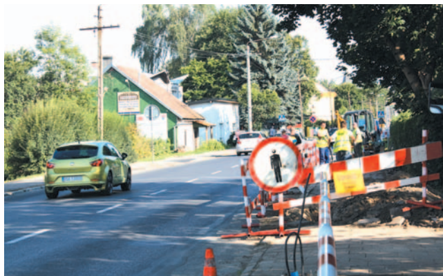
Z sanockich ulic znikają słupy, energetyka schodzi pod ziemię.
