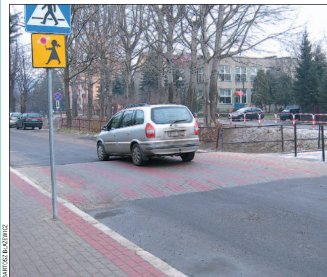
Próg pełni też funkcję przejścia dla pieszych – kierowca powinien przed nim znacznie zmniejszyć prędkość.
