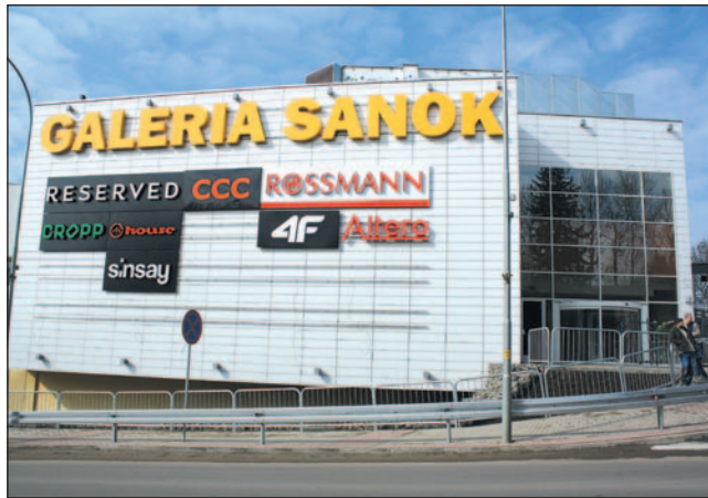
Galeria Sanok na pięć dni przed wielkim otwarciem.
