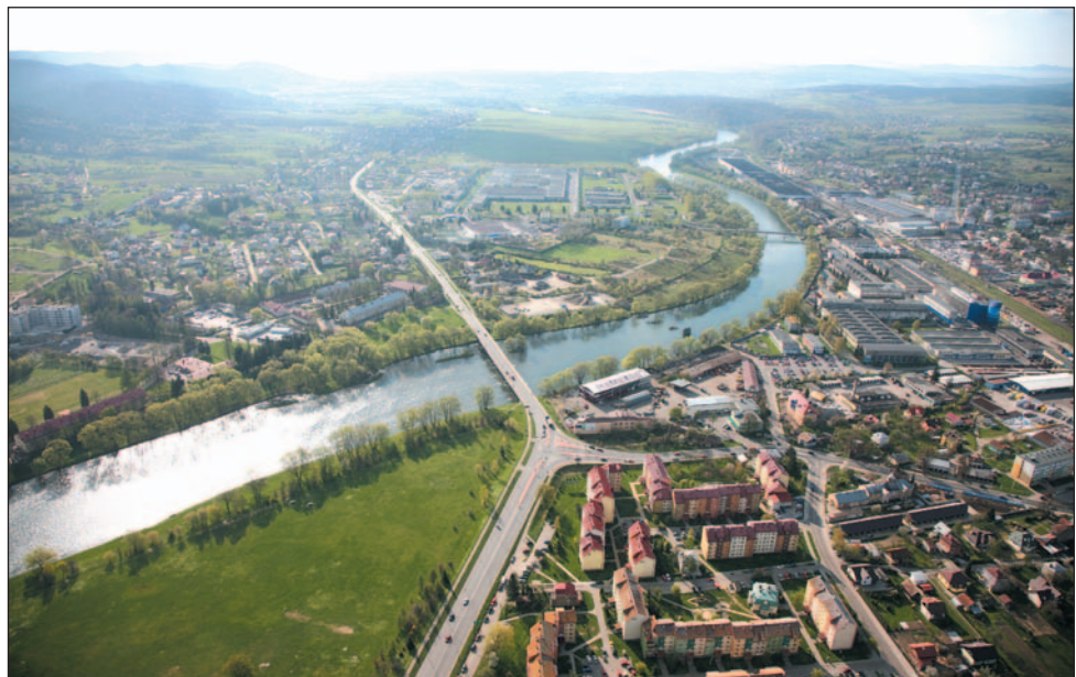
Najlepszym rozwiązaniem byłoby pozostawienie drogi nr 28 (na zdjęciu) i 84 w gestii GDDKiA. Jest nierealne, aby miasto utrzymywało i remontowało te trakty.
