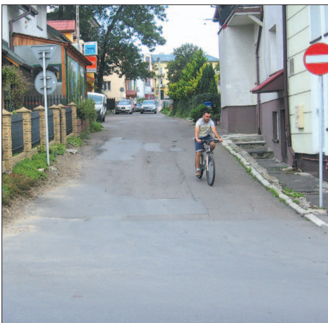
Chodnik przy ulicy F. Gieli jest niezbędnym.
