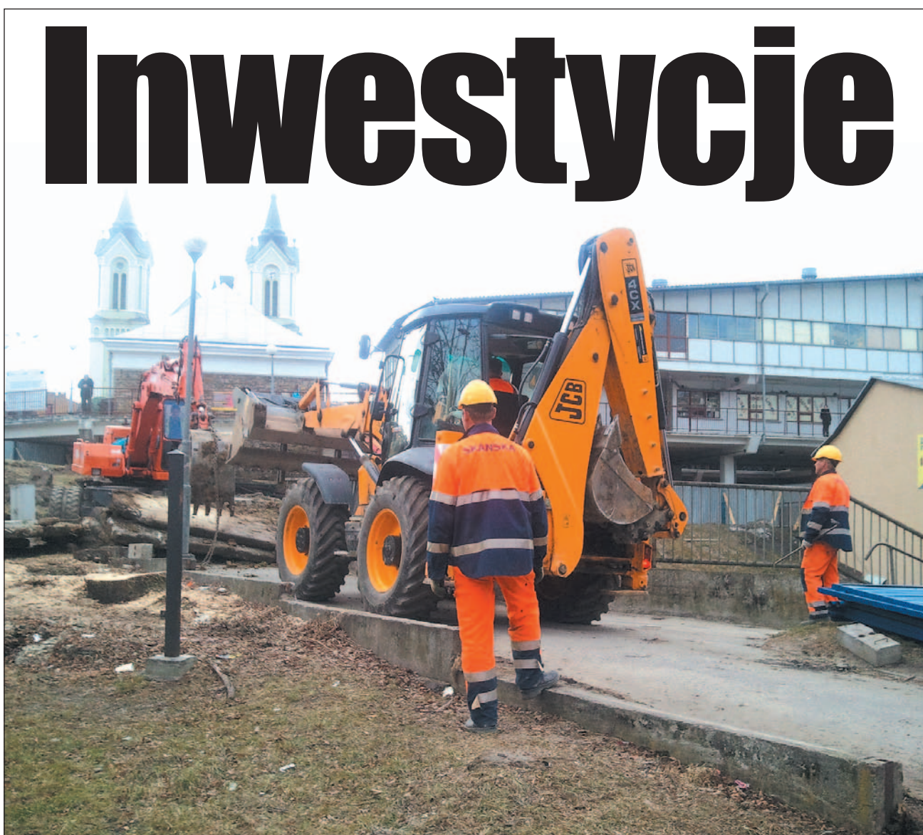
Parking wielopoziomowy, wybudowany w sąsiedztwie placu św. Michała, nie cieszy się popularnością wśród sanoczan, choć miejsc parkingowych w centrum brakuje. Na zdjęciu – rozpoczęcie budowy w marcu 2012 roku.
