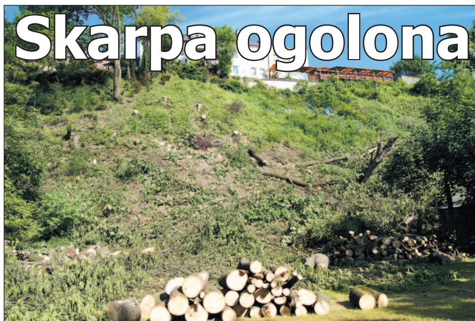
Wygolili, posprząтали. Wykonawca może wchodzić na plac budowy.
