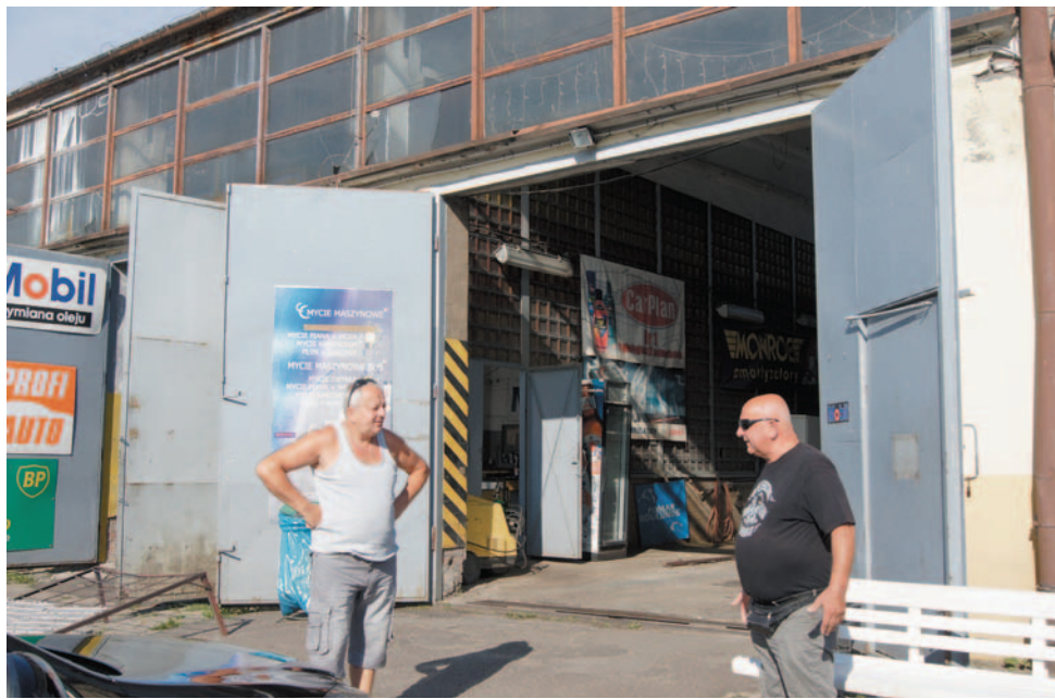
Auto Serwis funkcjonuje w tym miejscu od ponad 20 lat. Budynek, który firma użytkuje, wymaga solidnego remontu.
