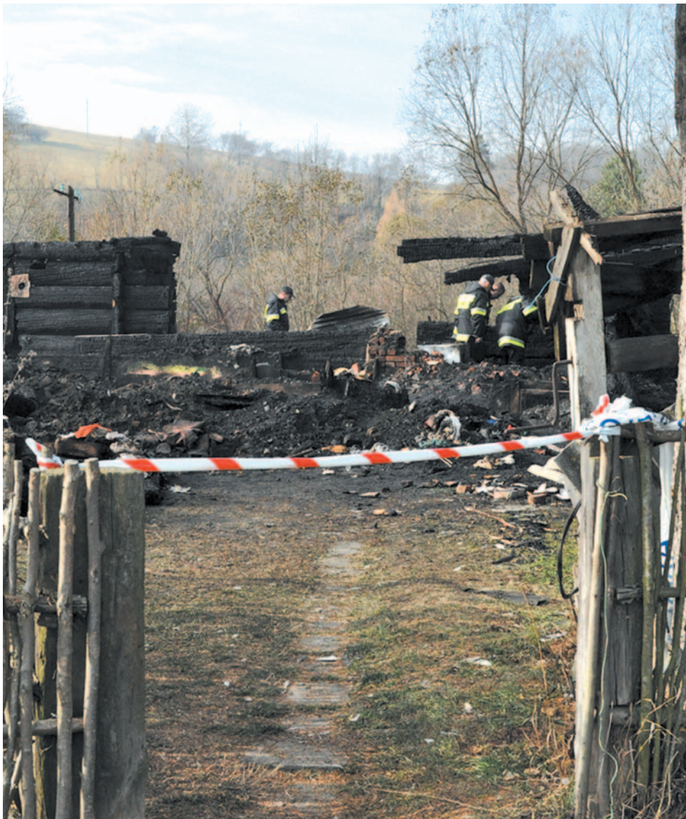
Dach drewnianego domu kilkakrotnie był kryty papą i smołowany. To wzmocniło siłę ognia
