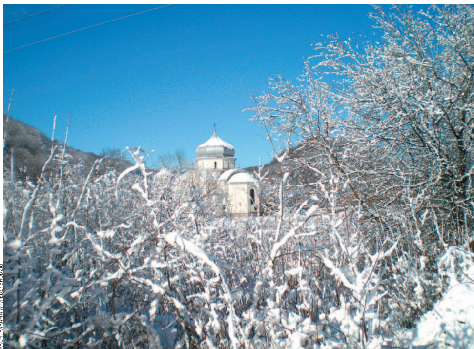
W ostatnich latach na remont cerkwi przeznaczono prawie 250 tys. zł
