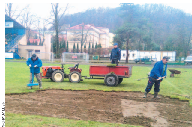
Obecnie trwają prace przy renowacji boiska
